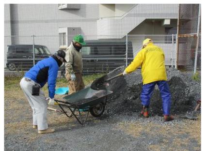
砂利を一輪車に積み込み運搬
