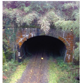
将来の複線化に備えて掘られた金辺トンネル
