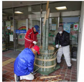
市民センターの外壁工事の足場がはずれ、玄関に立派な門松が飾られました。
