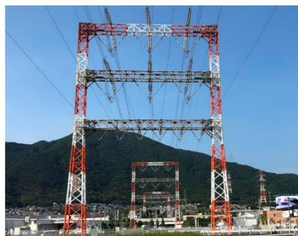
上には500kVが2回線、下には220kVが2回線併架されている門型鉄塔。ところで、子ども達に人気のキャラクター「ピカチュウ」が発する電気は10万ボルトという設定だそう。つまり、この送電線には「ピカチュウ×5匹分の電気が流れている！」と説明すると、子供たちには分かりやすい！？
